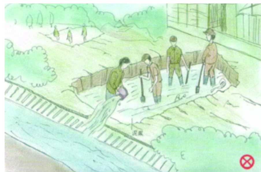
×施工泥浆未预处理直接排入市政污水管道
